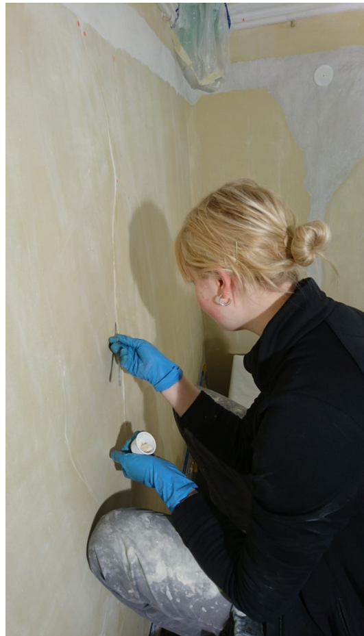
Salem, Abtsquartier, Februar 2020, Risskittung
